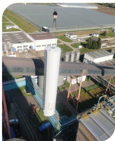
Montage Silo für Aktivkohle
